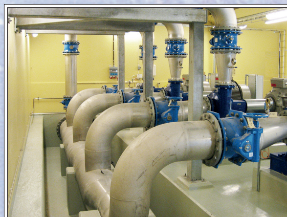
Sugledningar till de 4 pumparna.
