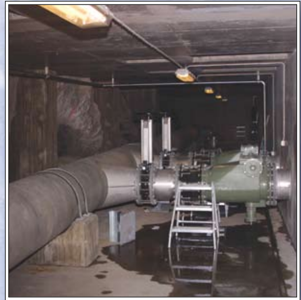
Pumpar med en kapacitet om 650 liter/sekund. Rostfria rör med en diameter av 700 mm. Total längd nere berget om 700 meter.
