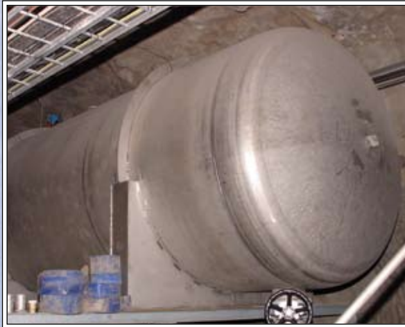
33 m 3 platsbyggt expansionskärl i rostfritt stål. Ihopmonterat och svetsat på plats.
