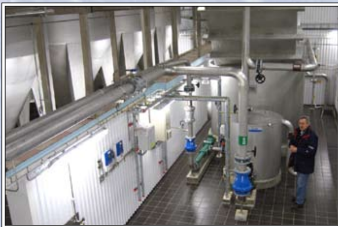
Till vänster 4 av 8 stycken nyinstallerade sandfilter.
