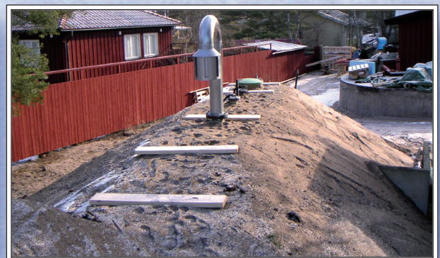
Lågreservoar med avluftning
