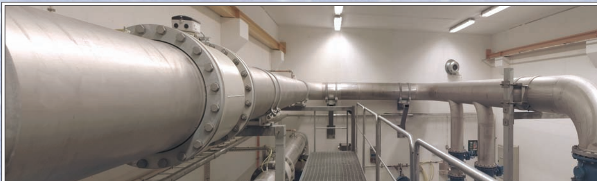
Rostfria rör med en diameter av 800 mm.
