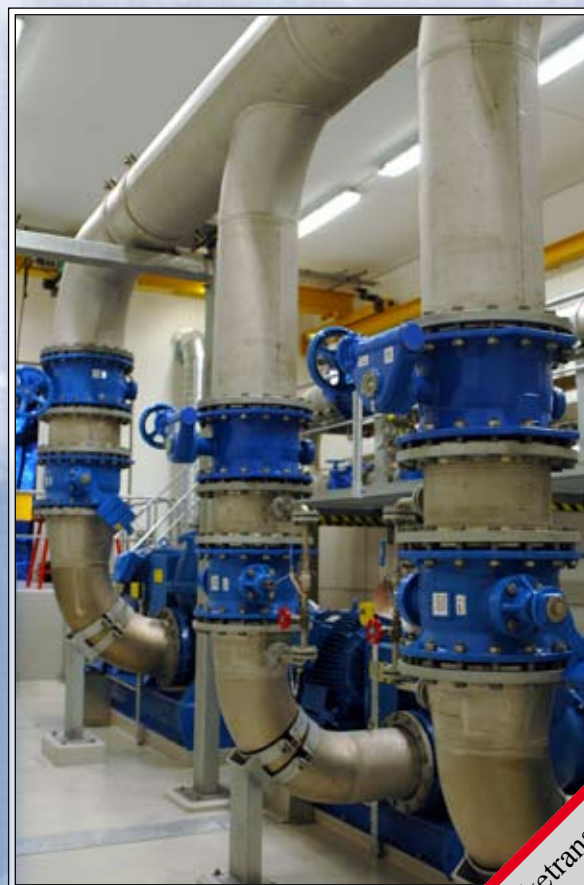
Anslutningar till två pumpar.
