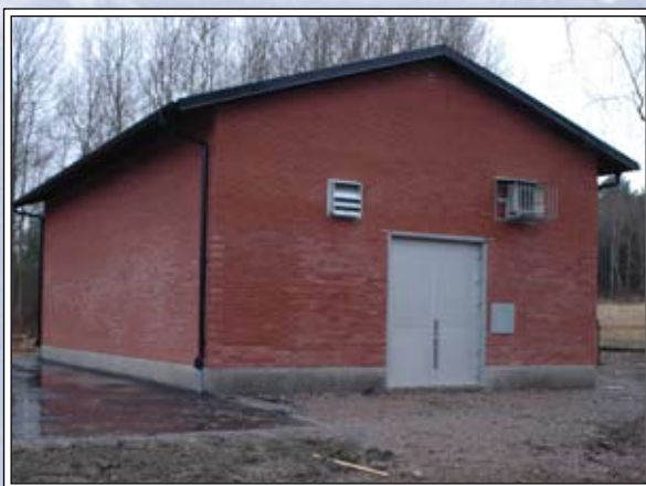
Exteriör. Pumpstation i drift.
