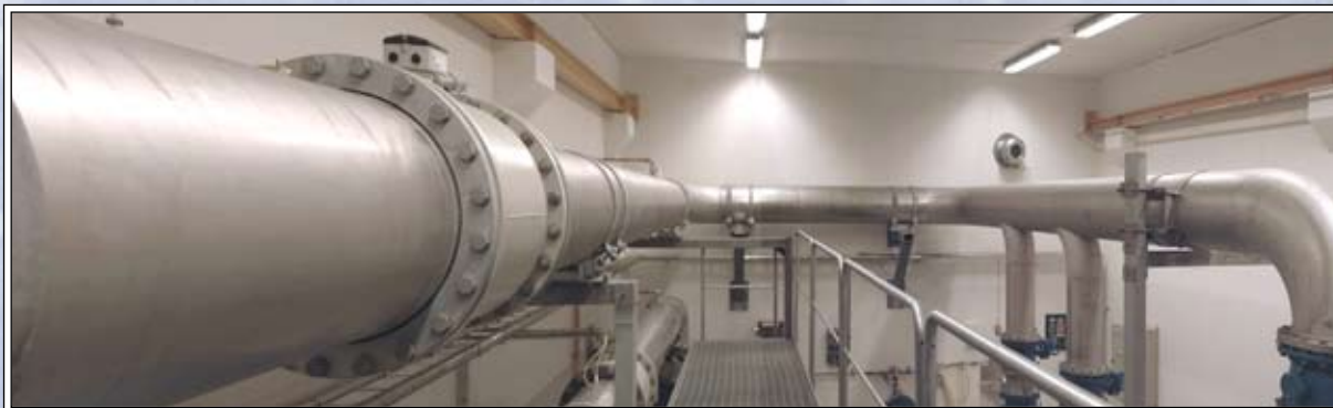
Rostfria rör med en diameter av 800 mm.
