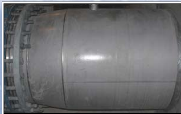
Förtillverkad kona från DN1000 till DN800 x t6
