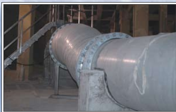
Böjar och stativ förtillverkade i egen verkstad
