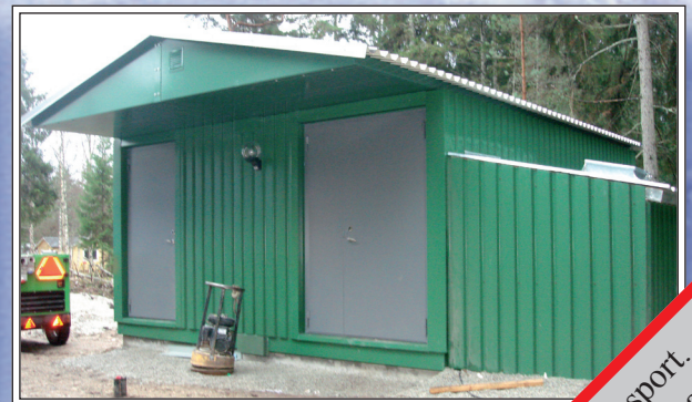
Vattenverket på plats.
