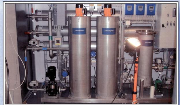
En, av två, inmonterade nanomembranenheter.
